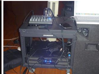
Foto No. 5 Planta y Mezclador
